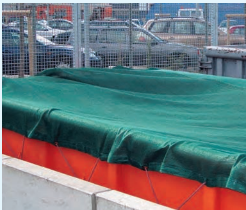
Sicherung mit luftdurchlässiger Plane
