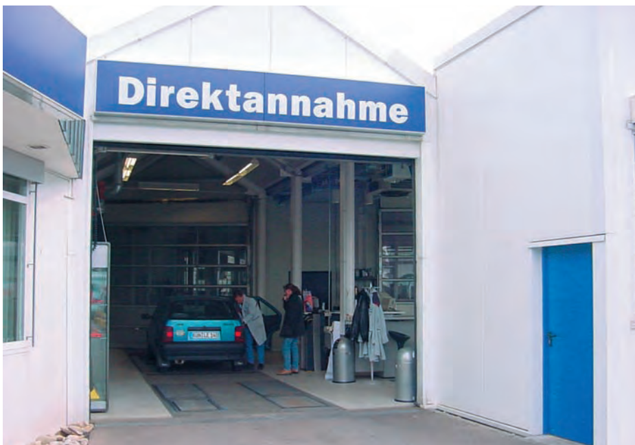
Abb. 4.3.1 Torluftgebläse beugen im Autohaus Klaiber (Fiat), Öhringen, im Winter Wärmeverlusten in der Direktannahme vor.
